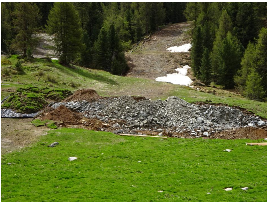
Schicht für Schicht: Zuunterst die Steine, in der Mitte die Erde, zuoberst die Grassiegel.
